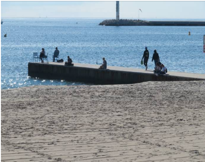
Plage de la croisette tous les exutoires sont prolongés au delà du banc de sable de la plage.
